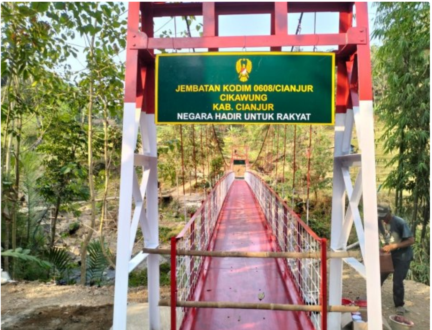
jembatan perintis garuda di sungai kawung sudah selesai 100%
